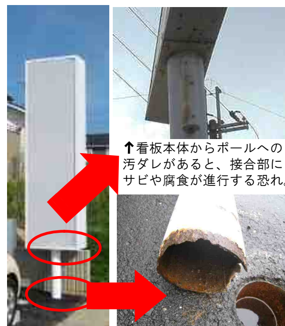
↑柱根元のサビを放置し、倒壊。
