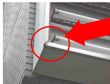
←パネルの変形、ズレ、破損の他、パネルの押さえ枠が変形し落下する場合も。
