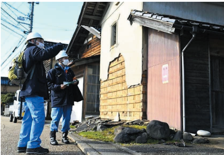
▲ 二次災害を防ぐために建物の応急危険度判定を行う本県職員（石川県穴水町）
