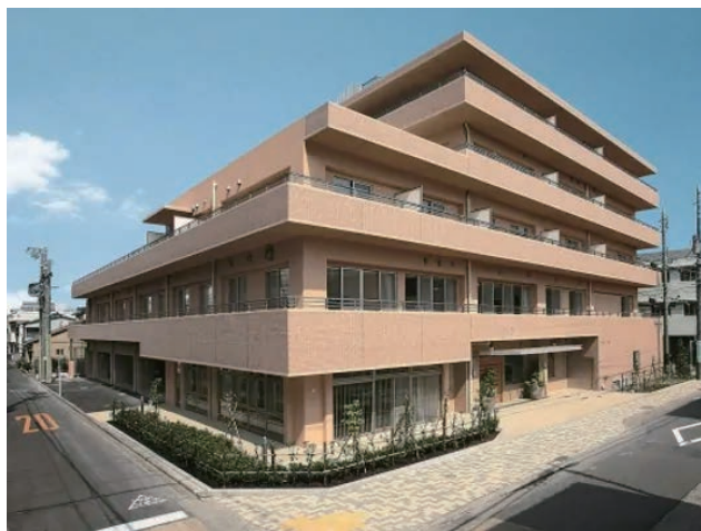
▲有料老人ホームの1つ・グライフ東鷹匠の外観(静岡市葵区)
