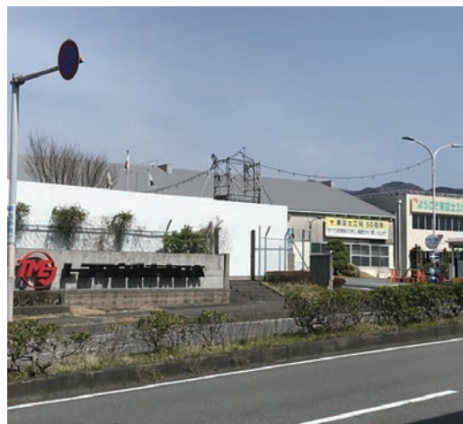
ウーブン・シティの建設予定地となっているトヨタ自動車東日本の東富士工場(静岡県裾野市)
