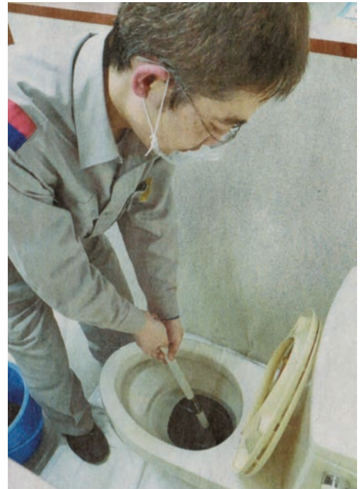
▲ラバーカップを排水口に押し当て、カップ内の空気を抜いたら、勢いよく引き抜く。
