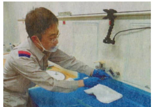
▼蛇口から水漏れしている時は、止水栓を閉めて水流を止めてからパッキンを交換する。
