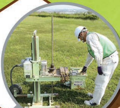
① 障害物調査 兼 地盤調査
