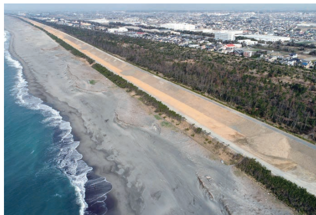
浜松市の遠州灘沿岸の防潮堤は大規模地震に備え全長約20キロ以上に及ぶ
