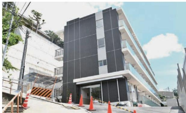
▲建物外観。写真左側が施工された高さ14.5mの擁壁
