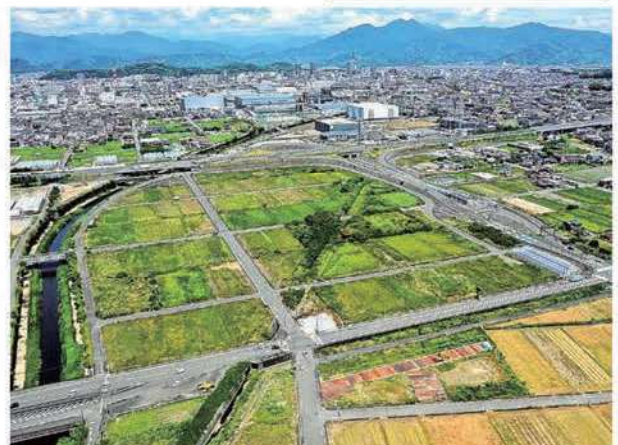
コストコが出店に向けて地権者組織と協議していることが分かった 東名高速道路・日本平久能山SIC南側用地（静岡市駿河区）
