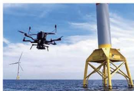
風力発電設備を点検するドローン
