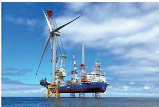
北海道・石狩湾新港沖で洋上風力発電の風車を施工する 清水建設の作業船「BLUE WIND」
