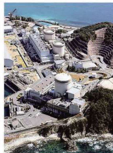
美浜原発。手前から3号機、2号機、1号機。
