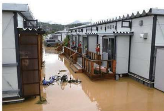
能登豪雨で冠水した仮設住宅団地(石川県輪島市宇田町)
